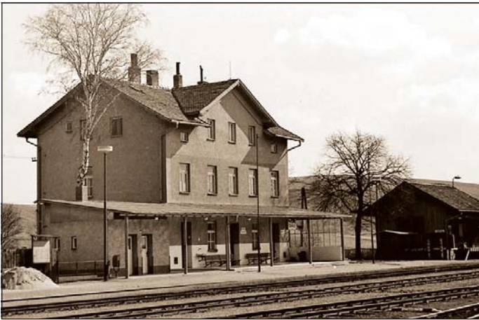
Nádraží ČD Ždánice v roce 2010 před zbouráním
