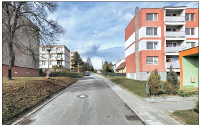
Bytová výstavba na sídlišti Padělky v letech 1960-2018
