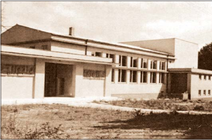
Kulturní dům postaven v roce 1965
