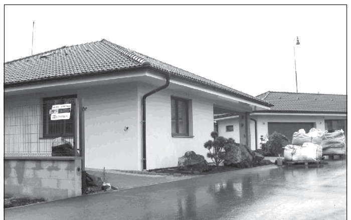
Zázemí stavební firmy
