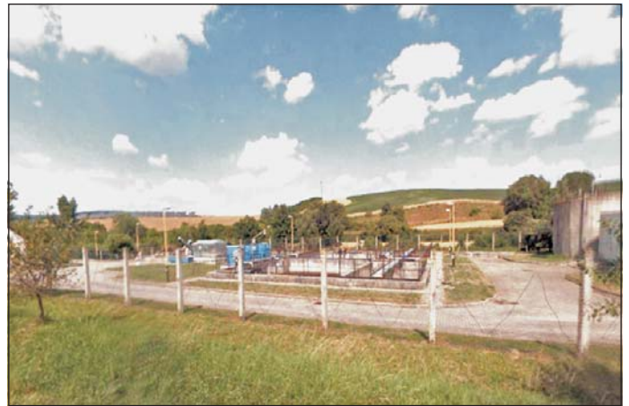
Čistička odpadních vod a kanalizace postavena v letech 1995-1997
