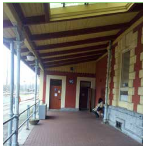
Železniční stanice v Jindřichově Hradci
